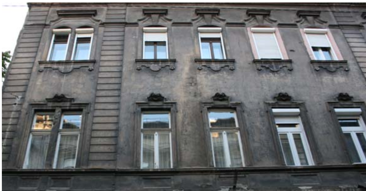
4. kép: Budapest, József körút 18. sz. alatti századfordulós lakóház Bacsó B. utcai homlokzata /2012.12.02/
